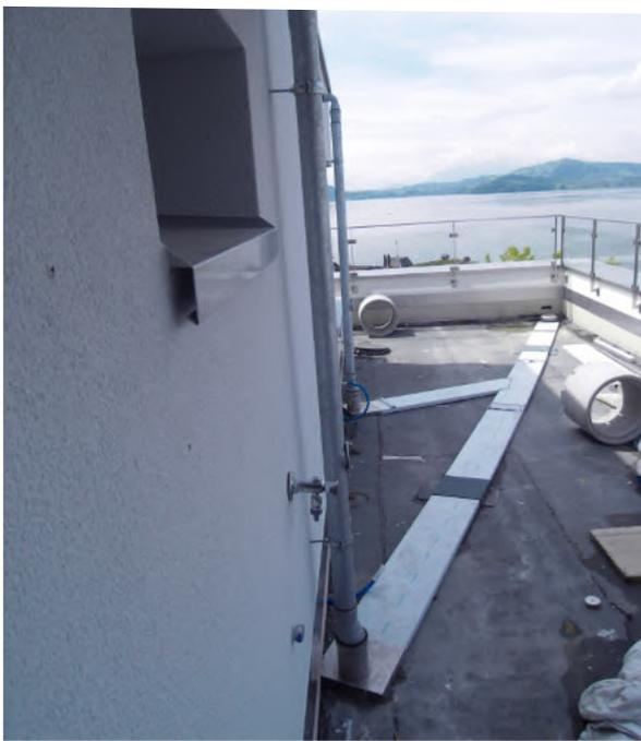
**MONSUN Flachkanal mit Rohrmuffe auf Feuchtigkeitsperre verlegt**
